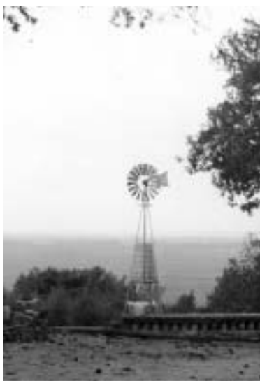
De Berg en Dalse "watertoren", een Amerikaanse windmolen met waterreservoir
